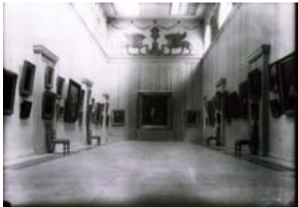
Intérieur de la Galerie des Griffons, 1947
